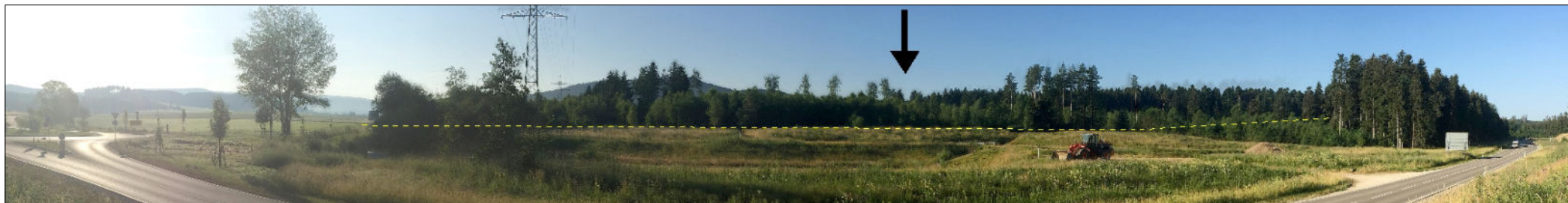
Abb. 5.2-3: Ansicht aus Norden auf das Plangebiet im Vordergrund K5910 daran anschließend Flächen des rechtskräftigen BBP Neuen mit einer Retentionanlage
