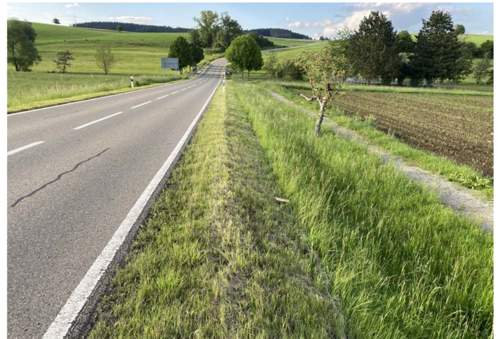
Blick nach Norden entlang K 5915, Bankett, Mulde, Grasstreifen mit 2 kleinen Obstbäumen, Splittweg, Ackerrain, Maisacker
