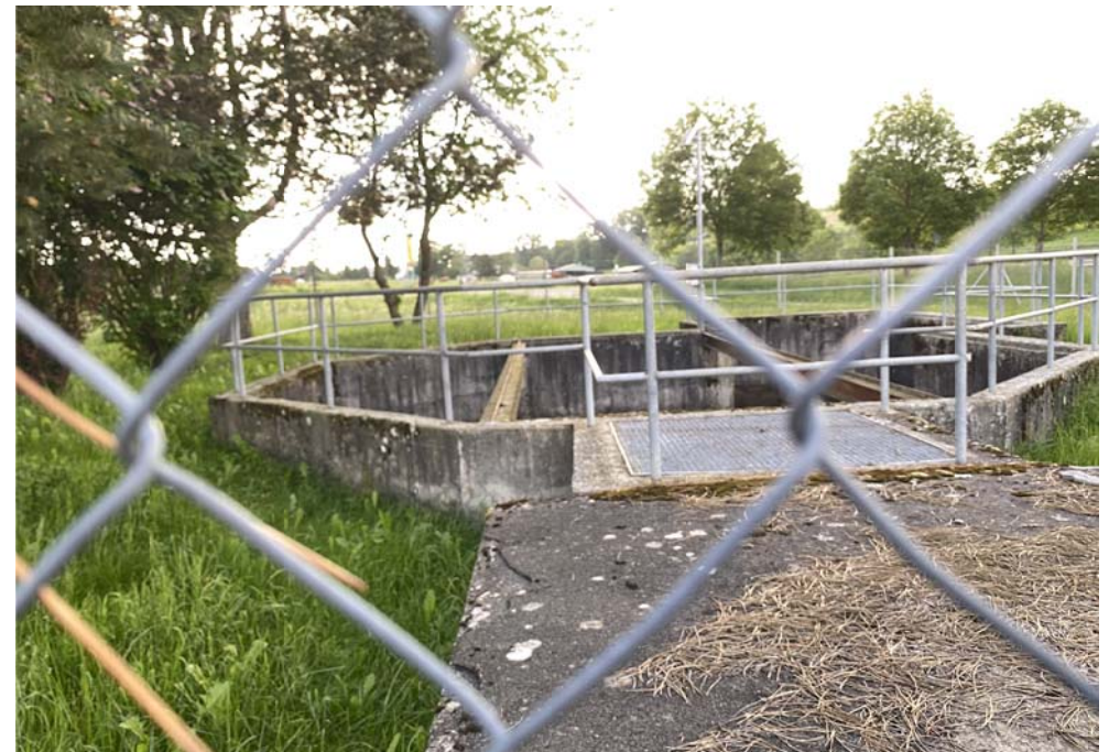
Regenüberlaufbecken nördlich Plangebiet, eingezäunt, 2 Kiefern, Kirsche, Ziersträucher
