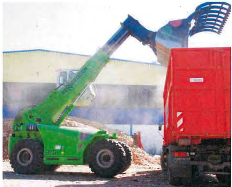
Umlade-Radlader in Abrollcontainer-Lkw mit „Greiferladeschaufel“
