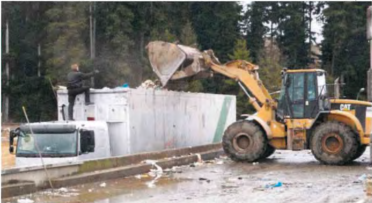
Radlader an der bestehenden Umladestation Lkr. Tuttlingen
